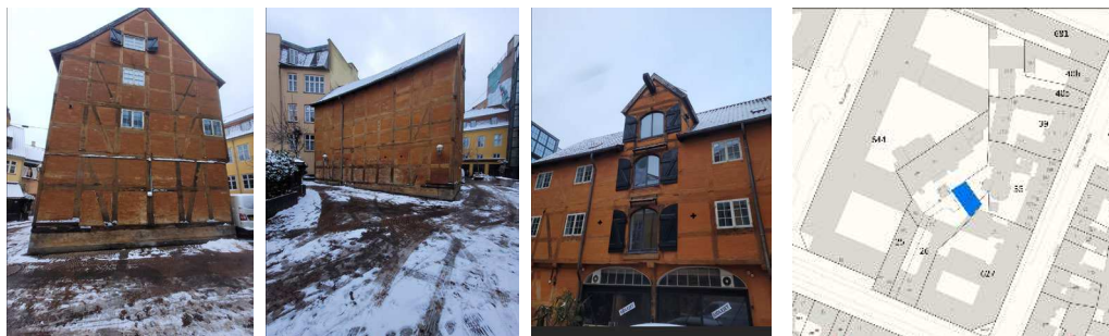
Baghuset Gothersgade 8 L
