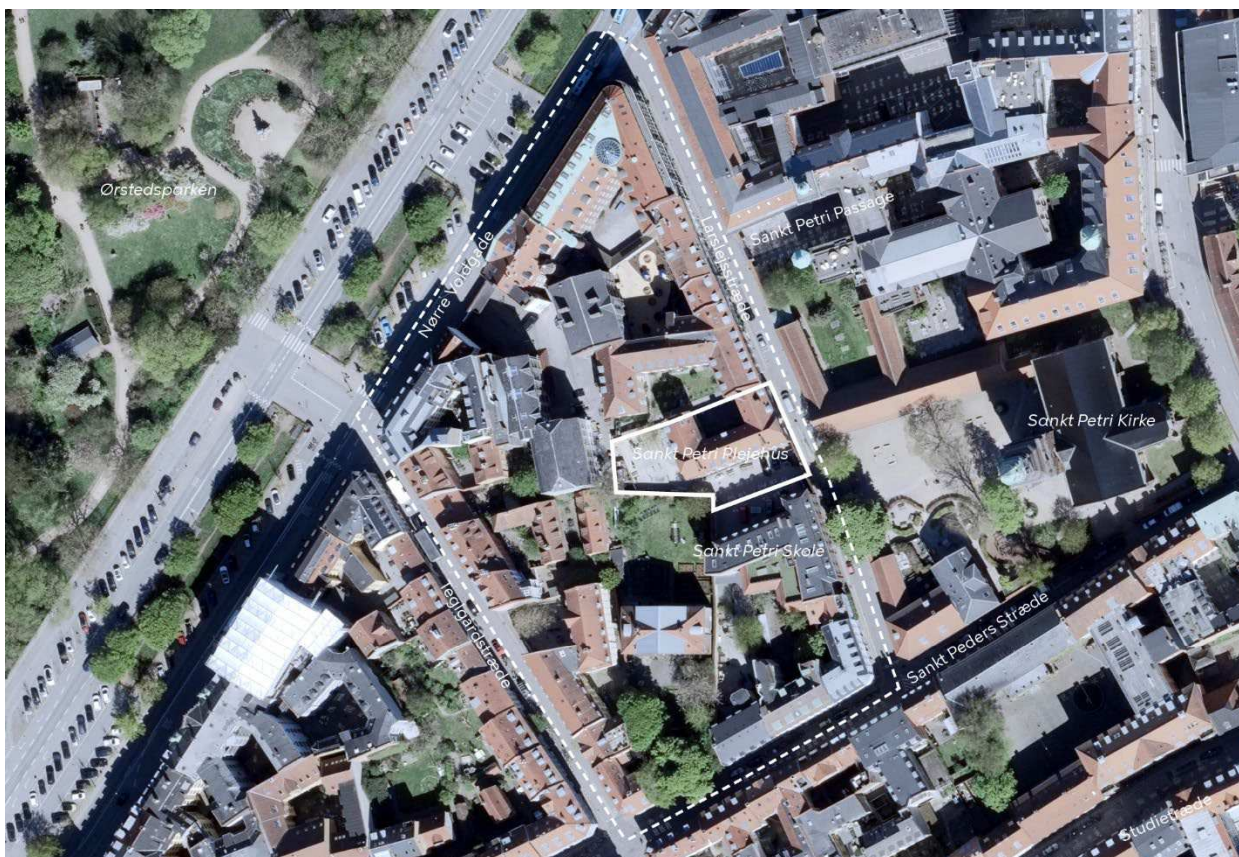
Luftfoto af lokalplanområdet. Lokalplan 311 Teglgaardstræde er indtegnet med hvid stiplede linje, lokalplanområdet er indtegnet med hvid linje og de vigtigste gader og bygninger er navngivet. Luftfoto: @geodanmark, 2025.
