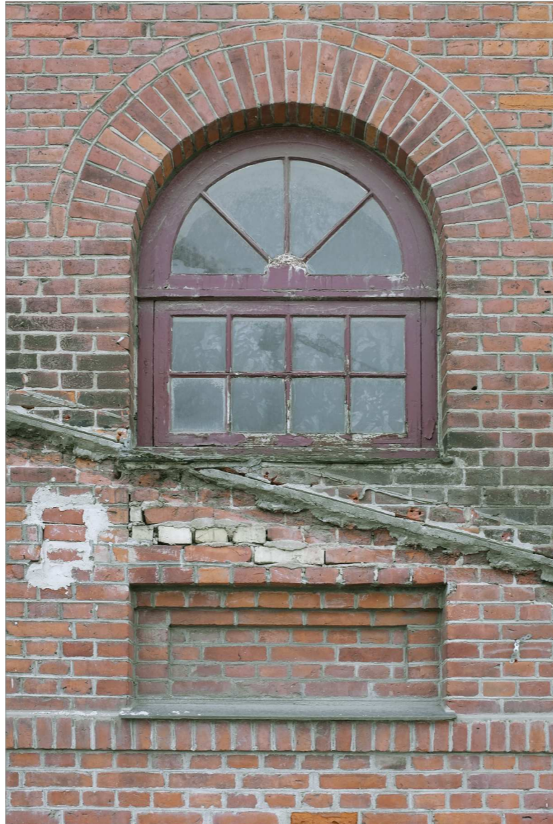
EKSISTERENDE VINDUE NORDFACADE
