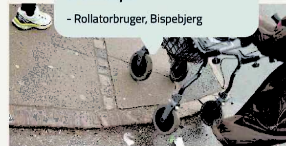
Manglende rampe. Bispebjerg.
