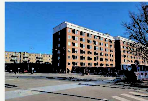
Tagensvej/Rovsinggade krydset med gode ramper.
