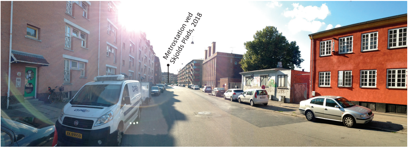
Sigurdsgade falder med ca. 3 meter fra øst mod den kommende metrostation ved Skjolds Plads i vest. (Foto: Københavns Kommune)
