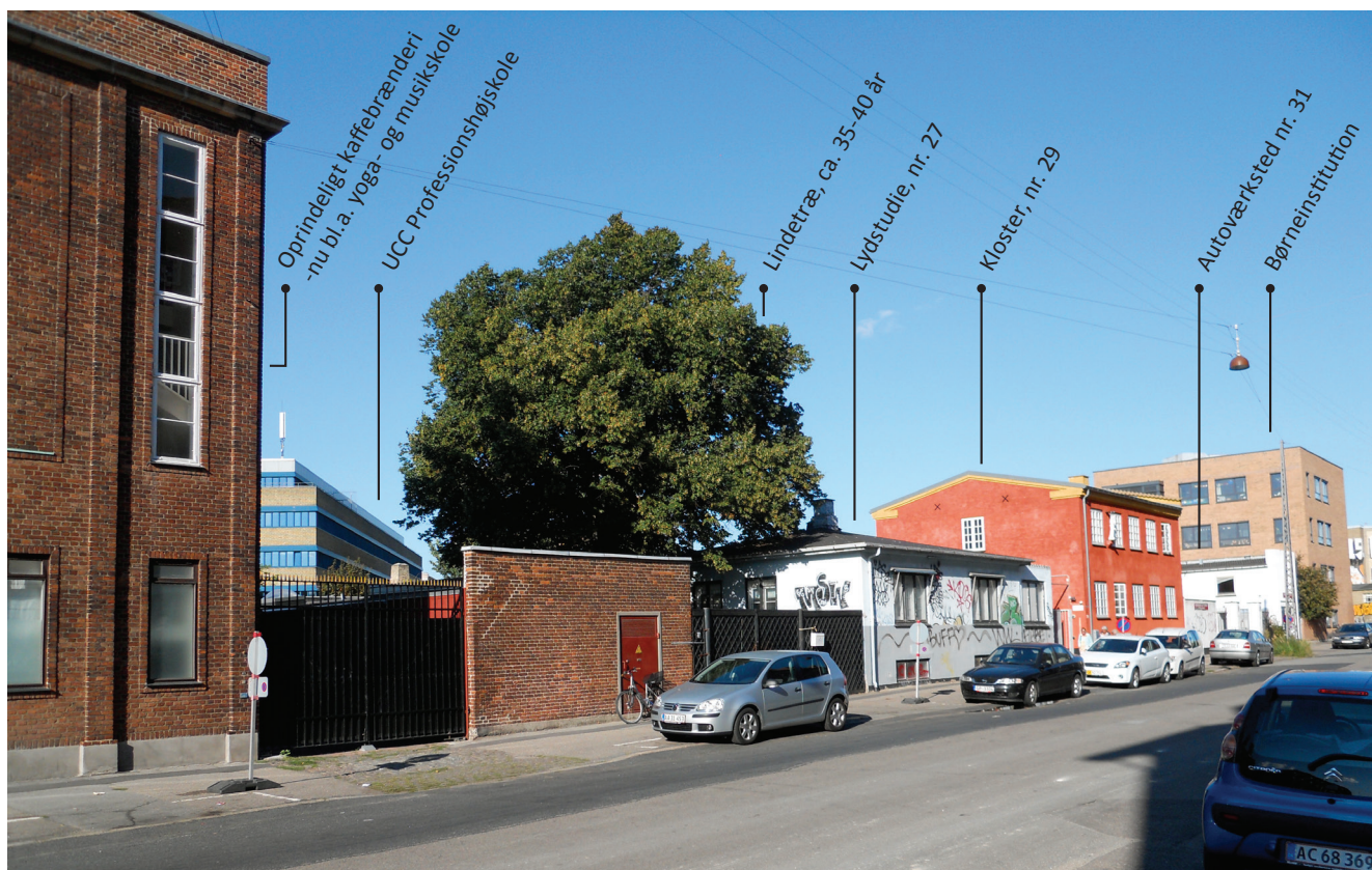
Bebyggelsen langs Sigurdsgade, som den fremstår i dag. (Foto: Københavns Kommune)
