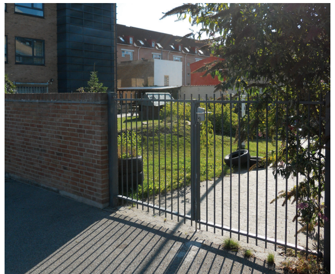
Porten og det lave murværk giver kig fra gade til gårdrum. (Foto: Københavns Kommune)
