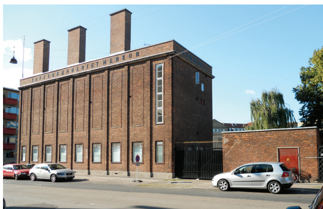
Denne treetagers fredede bygning rummede oprindeligt et kaffebrænderi. (Foto: Københavns Kommune)
