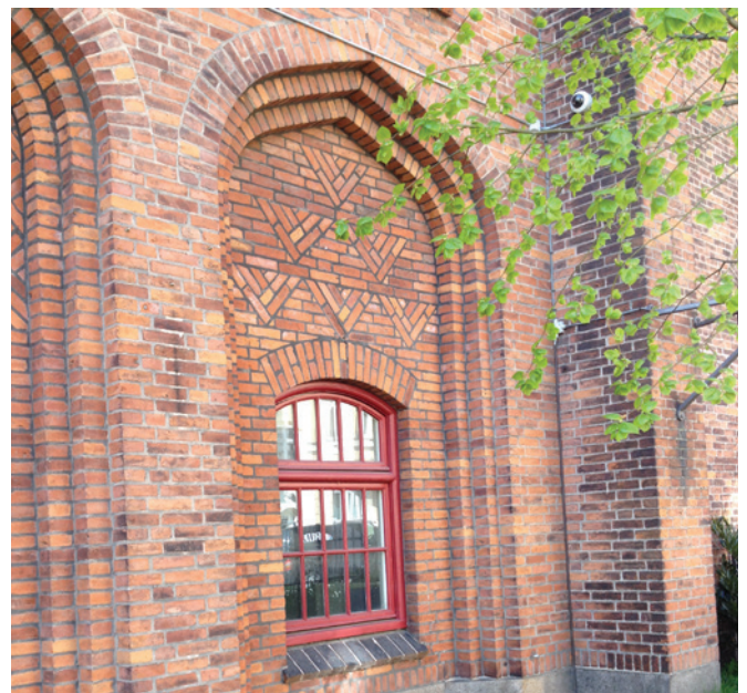
Eksisterende vinduesparti mod Thorsgade
