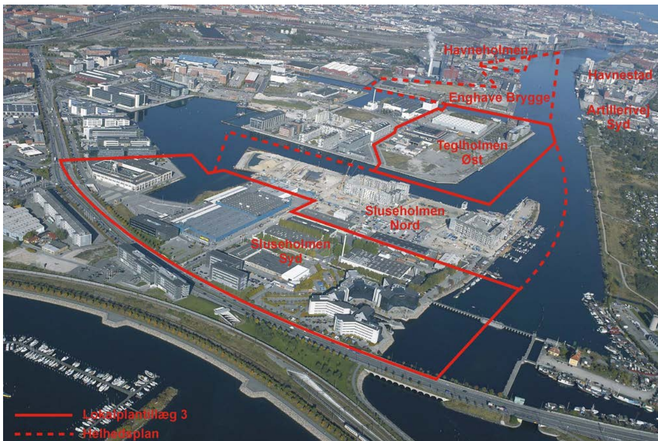
Luftfoto af lokalplanområdet set fra syd med afgrænsning af "Sluseholmen Syd" og "Tegllholmen Øst" samt området, der er omfattet af helhedsplanen. I forgrunden ses engros-supermarkedet Metro og Louis Poulsens produktionsområder. Langs Sjællandsbroen/Sydhavnsgade ses Sluseholmen nr. 8 "Nauticon", der bl.a. udlejes til LM Ericsson og Skattecenter København, kontorbyggeriet Sluseholmen nr. 2, der er opført i 2003 og til venstre i billedet den nu nedrevne Fordbygning. Midt for ved Teglværksløbet ses karreerne på Sluseholmen Nord under opførelse. (JW Luftfoto oktober 2005).
