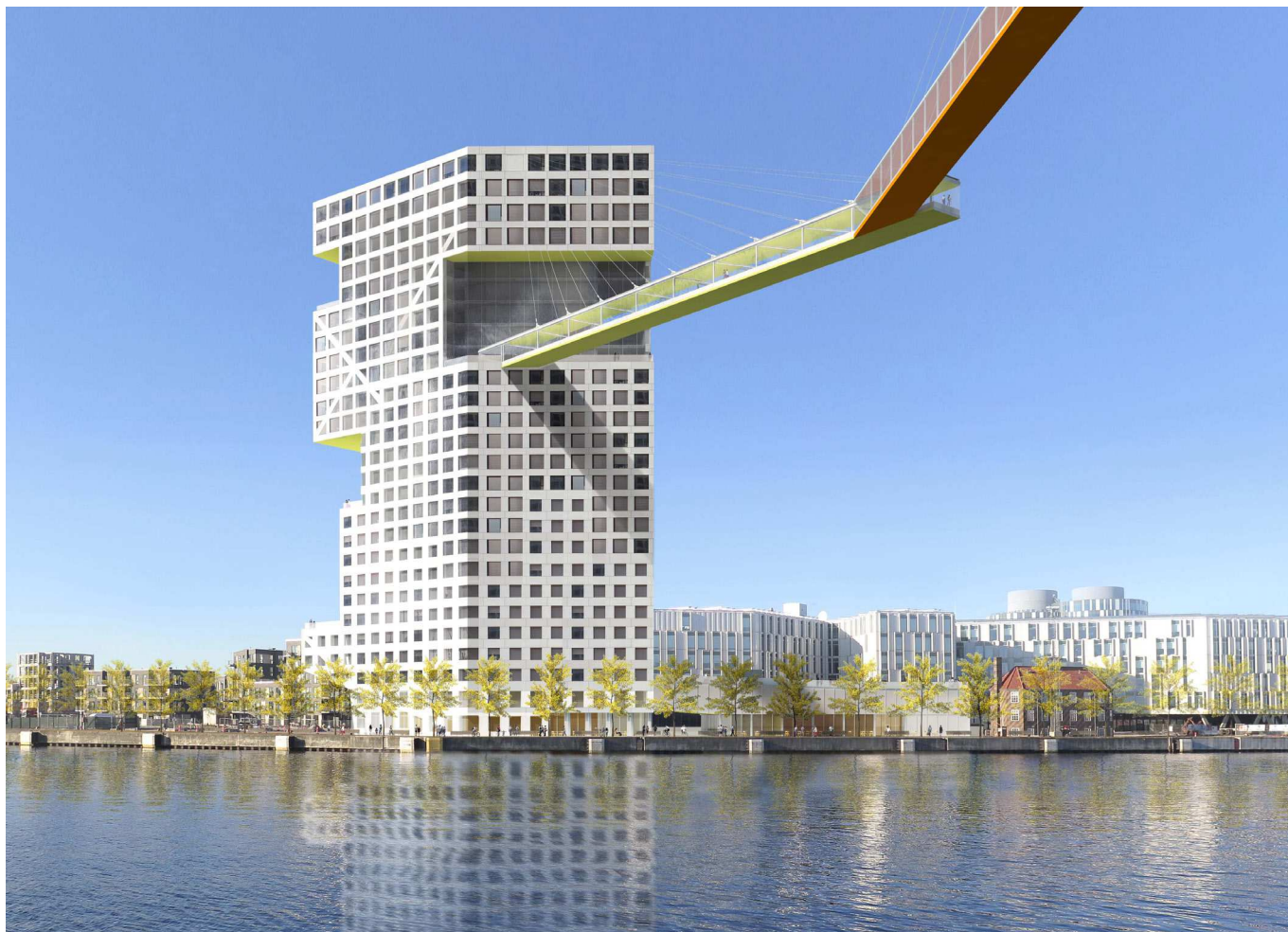
Højhuset på Marmormolen set fra Langelinie med 'Lodseriet', FN-byen og bolighalvværne i baggrunden. Ill: Steven Holl Architects.
