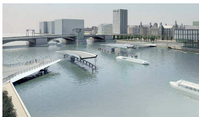
Broen i lukket og åben tilstand. Broen åbnes ved, at to drejelige fag vrider sig fri hinanden og placerer sig på langs i gennemsejlingsforløbet. Illustration: Wilkinson Eyre Architects.
