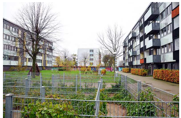
Remisevænget Øst til højre og tilhørende friarealer.
