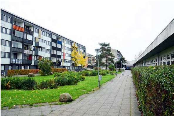
Fra Remiseparken mødes man til venstre af grønne friarealer. Til højre Solvang Centret og Remisevænget Øst til venstre. Set fra Remiseparken.
