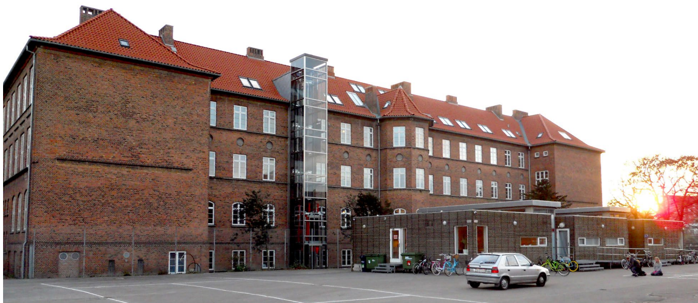
Billedet viser skolens nordfacade og den midlertidige bygning 'Spør 2'. Langs med facaden ses et mindst 2 m højt trådhegn.
