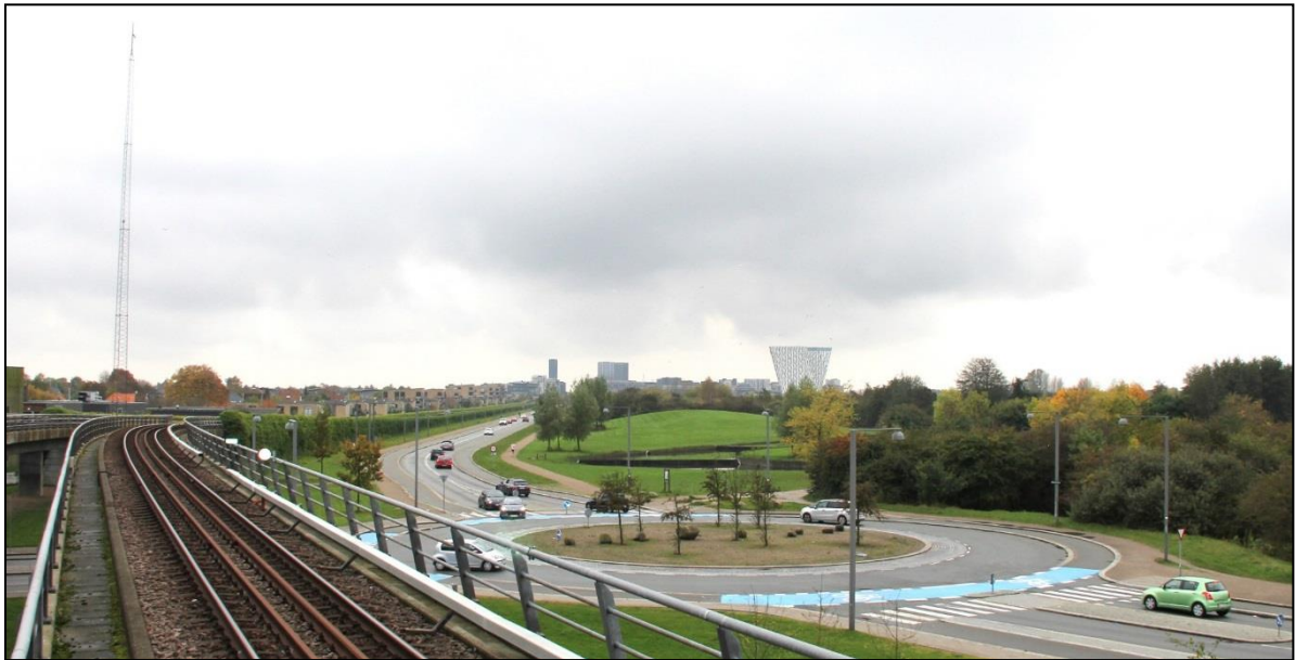
Figur 5-10. Eksisterende forhold ved perronen på DR Metrostation.
