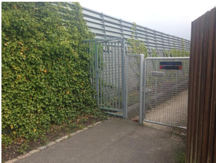
Eksisterende lukket sti ved haveforeningen Strandbo op ad metroens vestside. Roselillevej set fra nord – taget sydøst for Regitsevej 7
