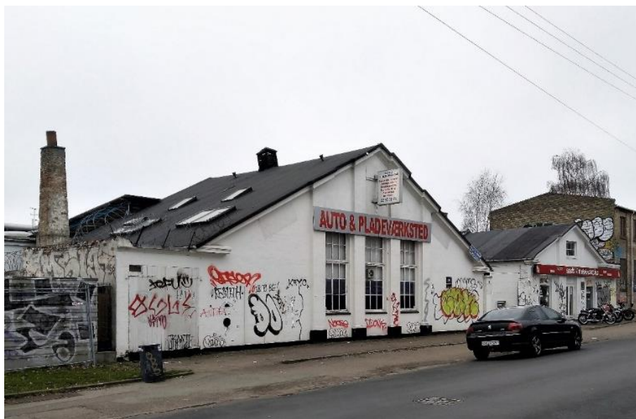
Karakteristiske værkstedsbygninger mod Rentemestervej der, bevares.
