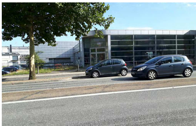
Bygning med middel bevaringsværdi indenfor område I (værdi 6), der kan nedrives.
