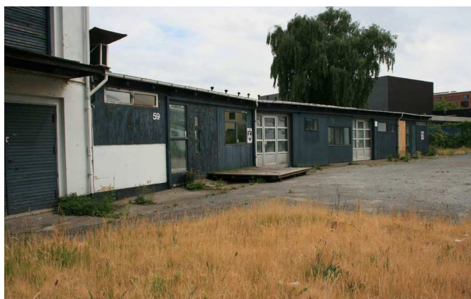
Bygninger inden for område I kan nedrives, herunder de barakagtige bygninger med lav bevaringsværdi (værdi 7).
