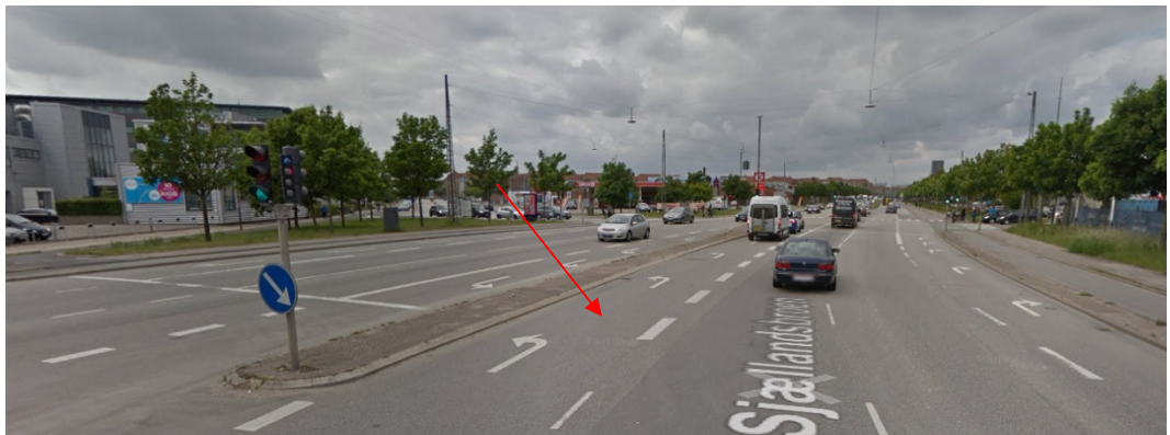
Figur 39 Venstresvingsbanen fra syd mod Borgmester Christiansens Gade fra Sydhavnsgade.
