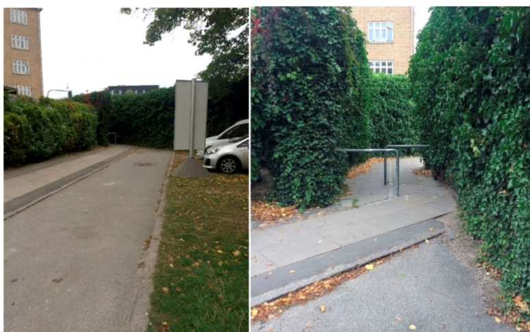
Billeder af eksisterende støjvæg og bomme fra Scandiagade mod Sydhavnsgade
