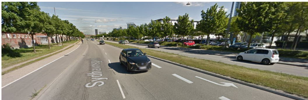
Figur 3 Sydhavnsgade set mod nord fra krydset ved Borgmester Christiansens Gade. (Google Streetview).
