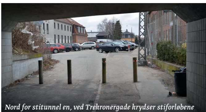
Stitunnel mellem Strømmen og Trekronergade
