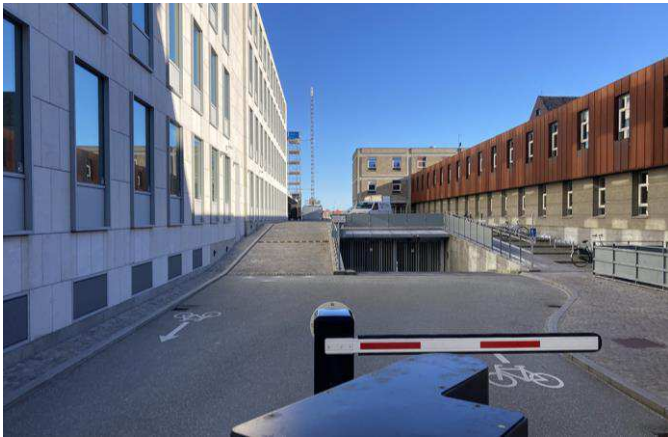
Passage mellem Amaliegade 44 og Esplanaden 50 med nedkørsel til p-kælder og stiforbindelse til havnepromenaden ved Inderhavnen.
