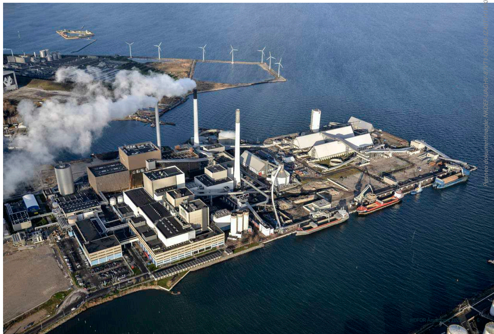
Amagerværket, der producerer fjernvarme til København
