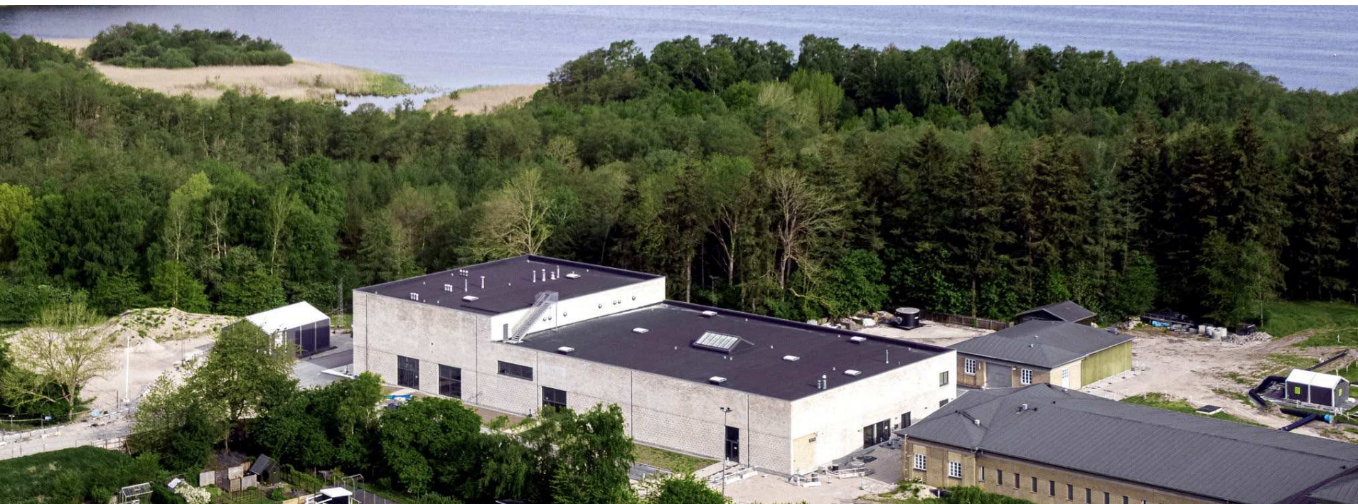
1. etape af Værket ved Sønder sø stod færdig i 2022
