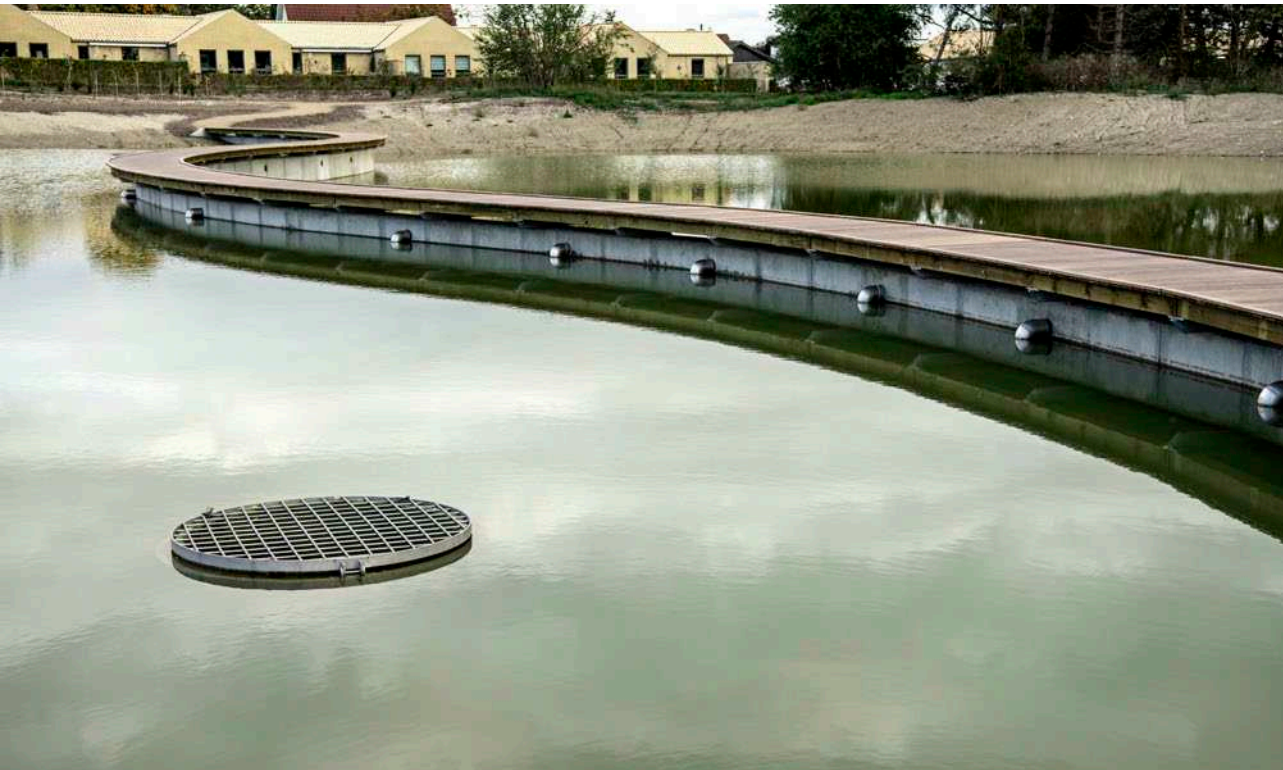
Klimatilpasningsanlægget på Strandengen i Vallensbæk stod færdigt i 2021
