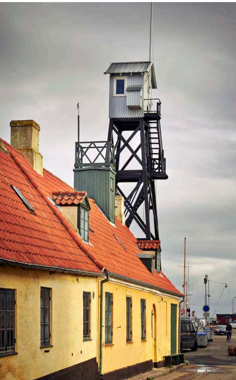
Gule huse ved havnen i Dragør
