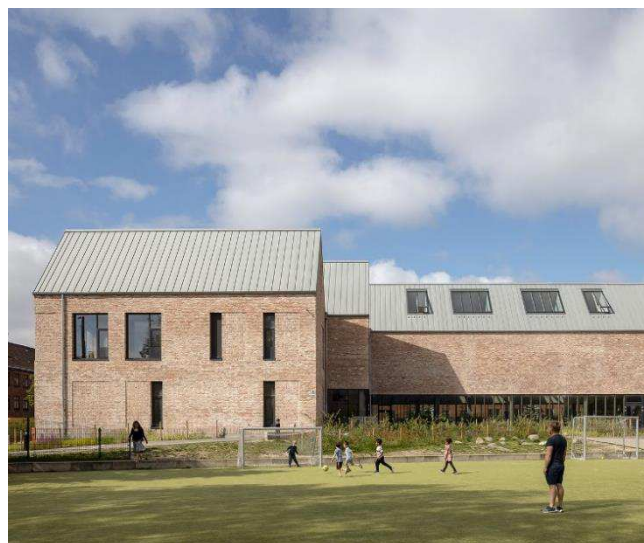
Ved renoveringen af Grøndalsvængets Skole blev ovenlysvinduer brugt til at sikre tilstrækkeligt dagslys i de nye skolefaciliteter.
