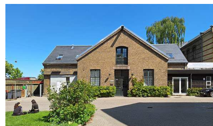
Bygning 6. Ishus og desinfektionsbygning.
