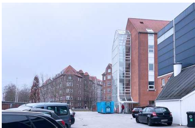
Foto, der viser den bygning der nedrives.
