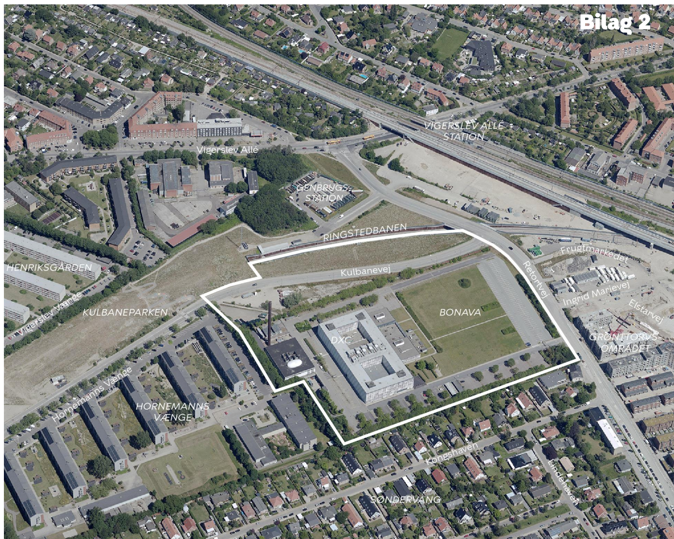
Området set mod nord. Lokalplanområdet er indtegnet med hvid linje og de vigtigste gader og bygninger er navngivet. Luftfoto: Kortforsyningen, 2019.
