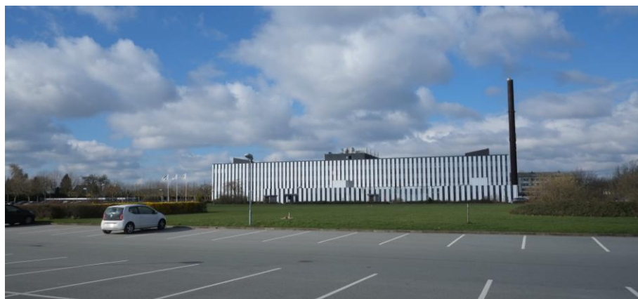
DXC set fra parkeringsarealet ved Retortvej. Foto: Arkitema
