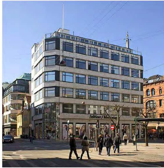
Ill. 2 Tagetagen er trukket tilbage, så huset opleves mindre og skygger mindre mod "Magasins Torv". (Ill. Rönby.dk)
