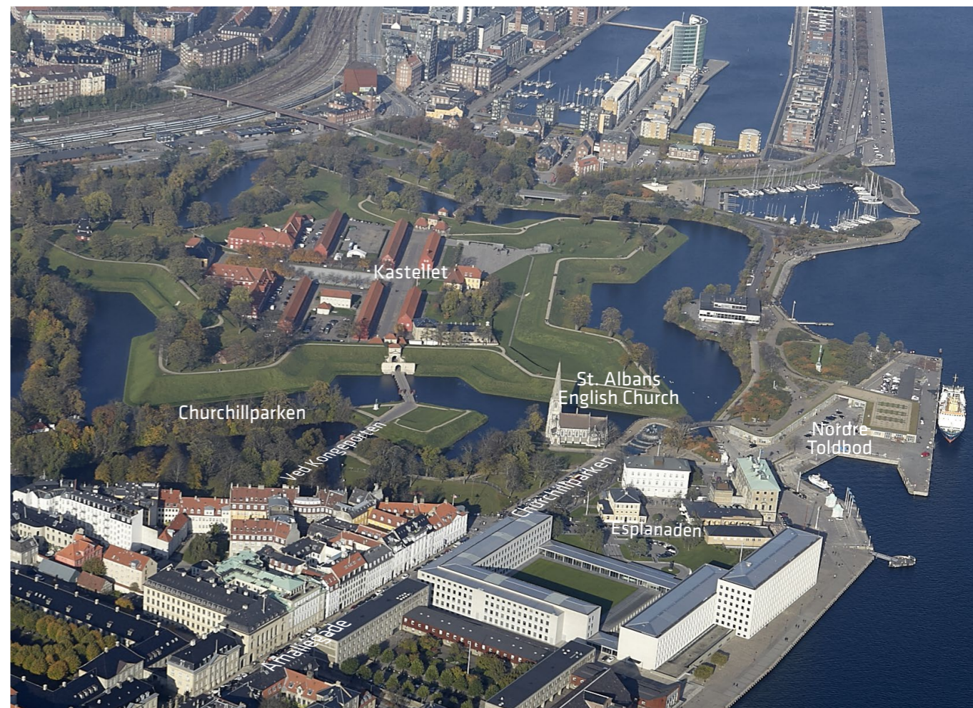
Luftfoto, set fra syd. JW luftfoto, oktober 2014.
