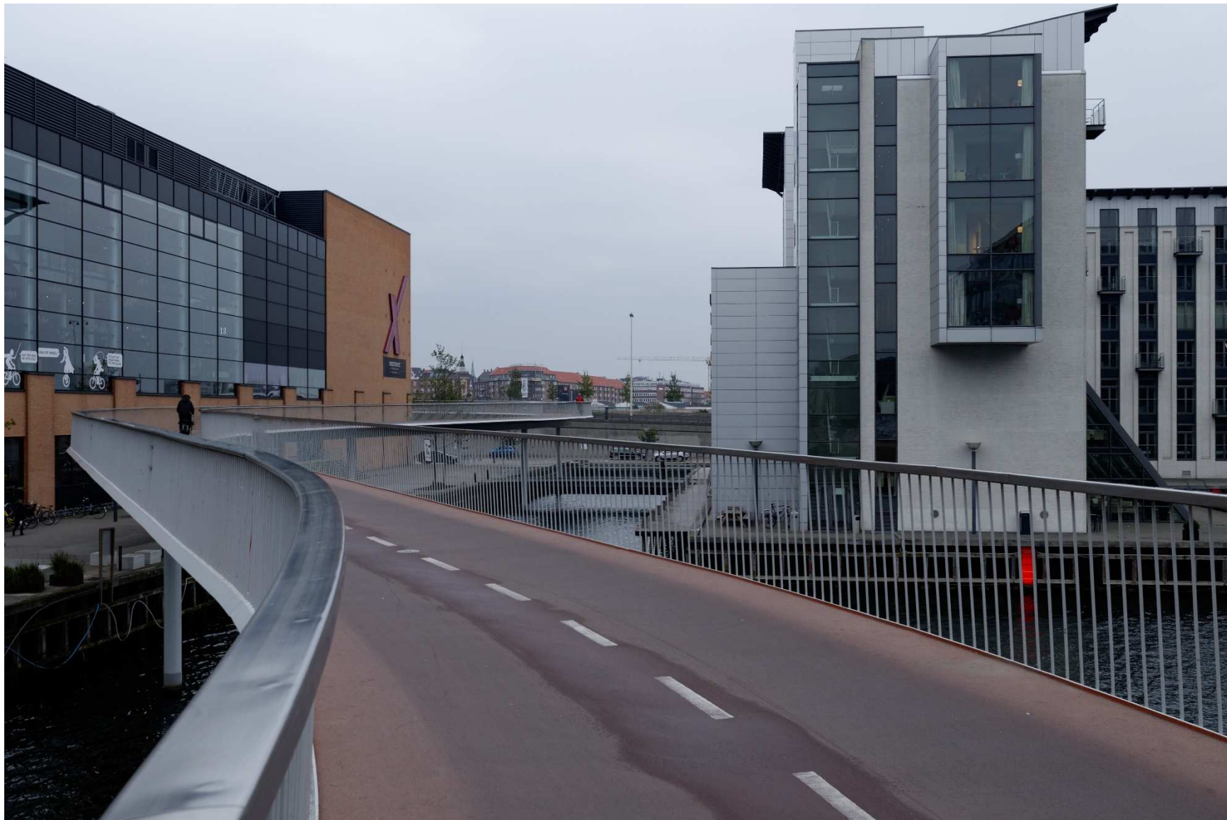
4A. Udsigt fra Cykelslangen mod Dybbølsbro – før
