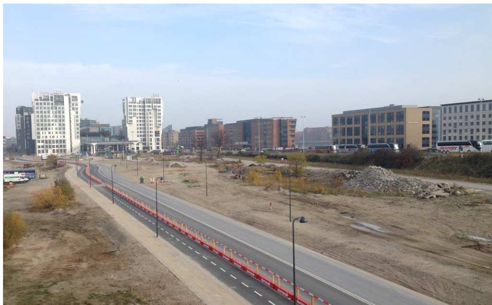
Figur 11-2 Projektområdet henligger primært som en ubevokset grusflade. Den nordlige del af projektområdet ses her til højre for den nyanlagte Carsten Niebuhrs Gade. Foto er taget fra Dybbølsbro november 2015.
