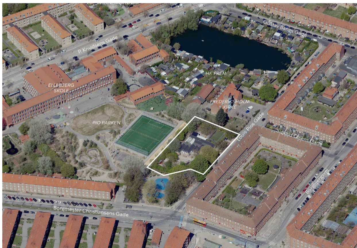
Området for Louis Pios Gade 12 set mod nord. Lokalplanområdet er indtegnet med hvid linje, og de vigtigste gader, pladser og bygninger er navngivet. Luftfoto: Klimadatastyrelsen, 2023.
