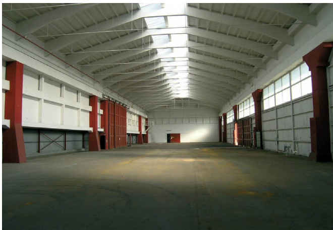
'Specialstålhallen' indvendig. Foto: DesignGroup Architects
