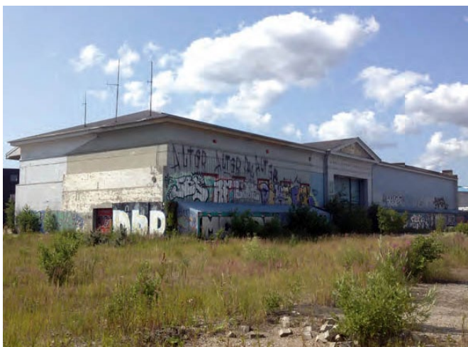
'Specialstålhallen' set fra Vasbygade. Foto: DesignGroup Architects
