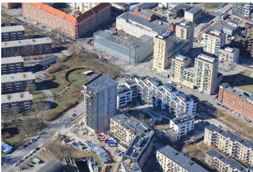
Strandlodsvej 48 – Tilbygget med 2 til 4 etager.
