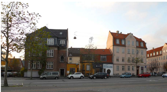
Amagerbrogade overfor Sundbyøster Plads Overfor Sundbyøster Plads er der en mere uens facadebebyggelse
