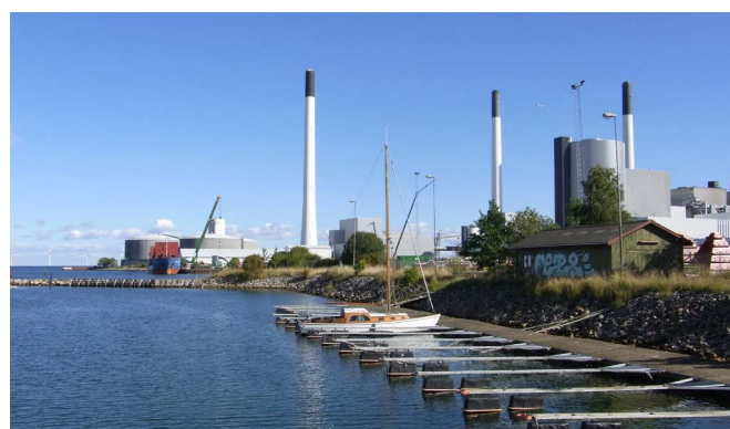
Amagerværket set mod nordøst
