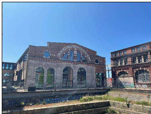
Bevarede værkstedsbygninger omkring den gamle tørdok
