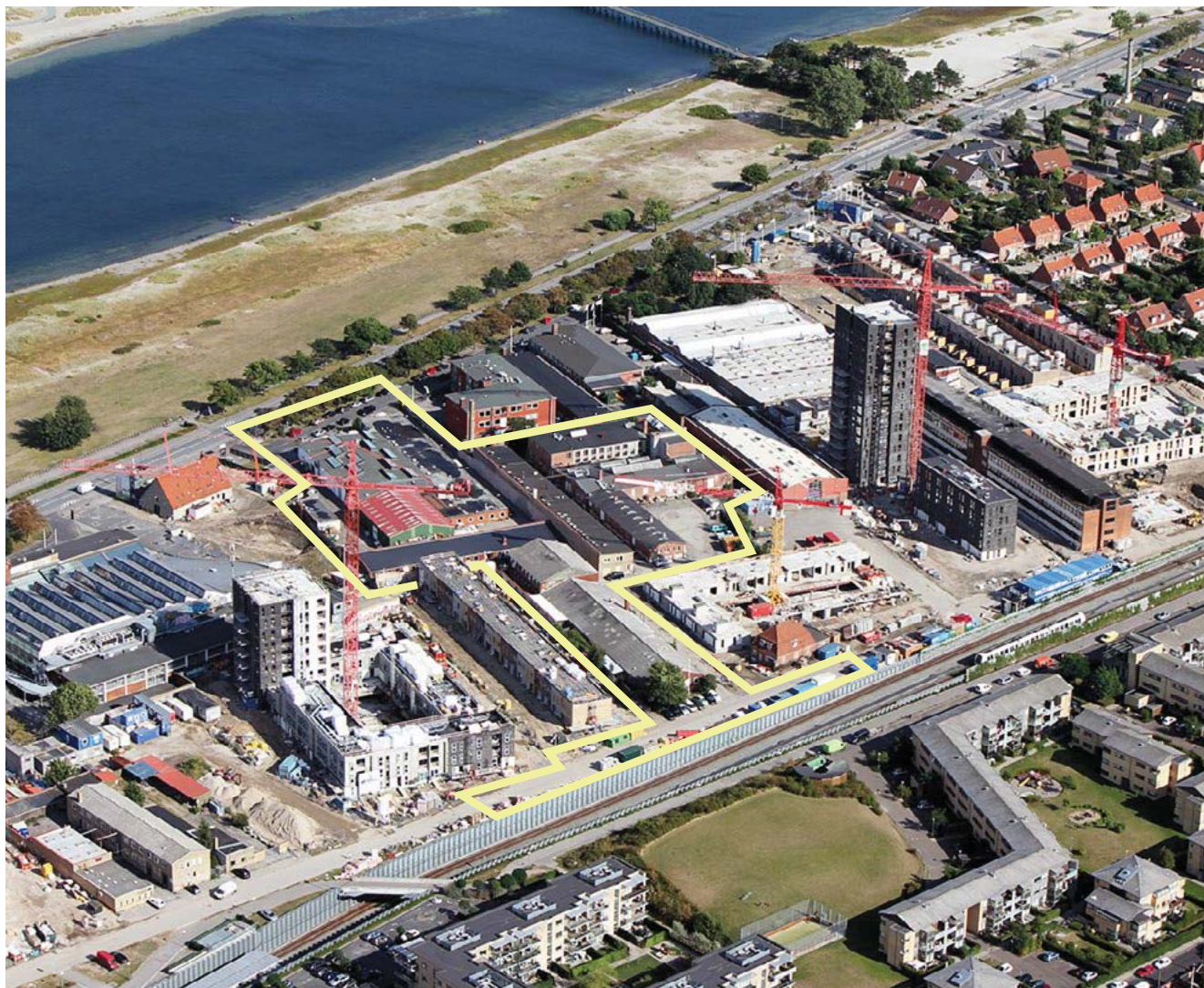
Luftfoto af lokalplantillægsområdet, som er indtegnat med orange streg. Luftfoto taget mod øst af Jesper Sørensen 2013.
