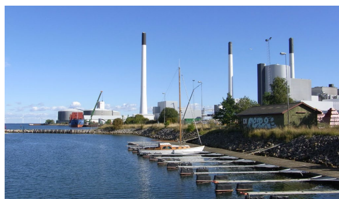
Amagerværket set mod nordøst
