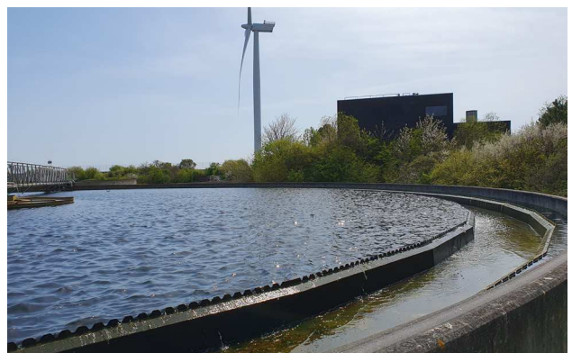
Billede 8 Efterklaringstanke
