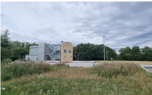
Billede 5 Ny mellempumpestation
