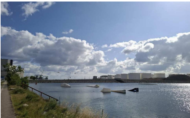
Billede 7 Cykelsti langs Kraftværksvej - bro til jordtransportvej
