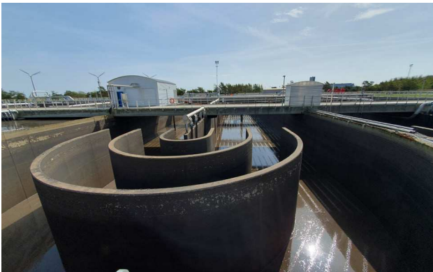
Billede 3 Luftningstanke
