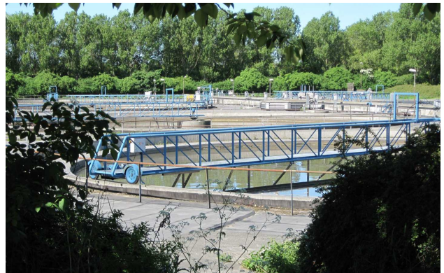
Billede 4 Forklaringstanke © BIOFOS
