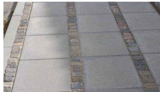
Eksisterende københavnerfortov bevares
