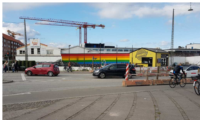
Bygningerne på hjørnet af Skelbækgade og Ingerslevsgade bl.a. bygning 7 og 8, Kødboderne 16-18 og Kødboderne 2-14 vil kunne nedrives i forbindelse med nyt skolebyggeri på grunden. Lokalplanen muliggør nedrivning. Øvrige bygninger inden for område IV vil også kunne nedrives.
