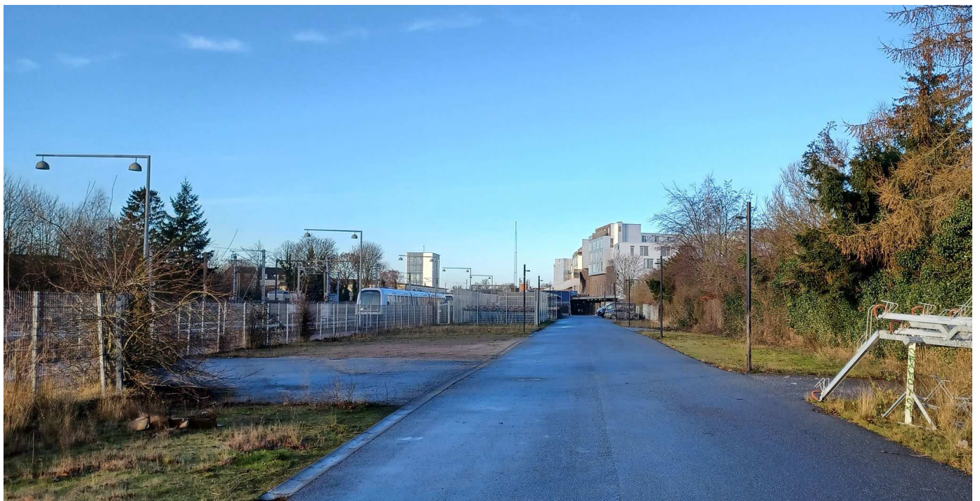
Billede fra friarealet i den østlige del af lokalplanområdet.
