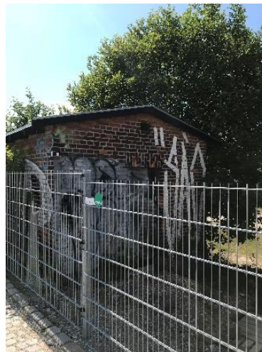
Figur 12. Bygning 2 – Pumpestation mod Carsten Niebuhrs Gade, set mod sydvest.
