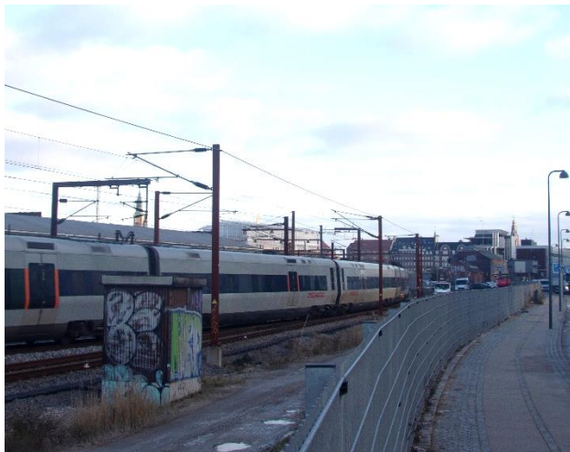
Figur 11. Bygning 1 - Sikringskab mod jernbanen, set mod nordøst.
