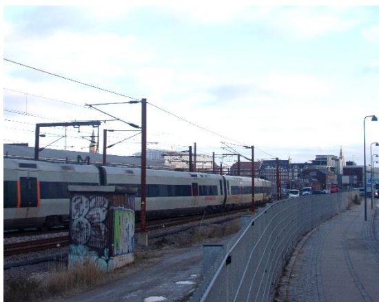
Figur 39. Bygning 1 - Sikringsskab mod jernbanen, set mod nordøst.
