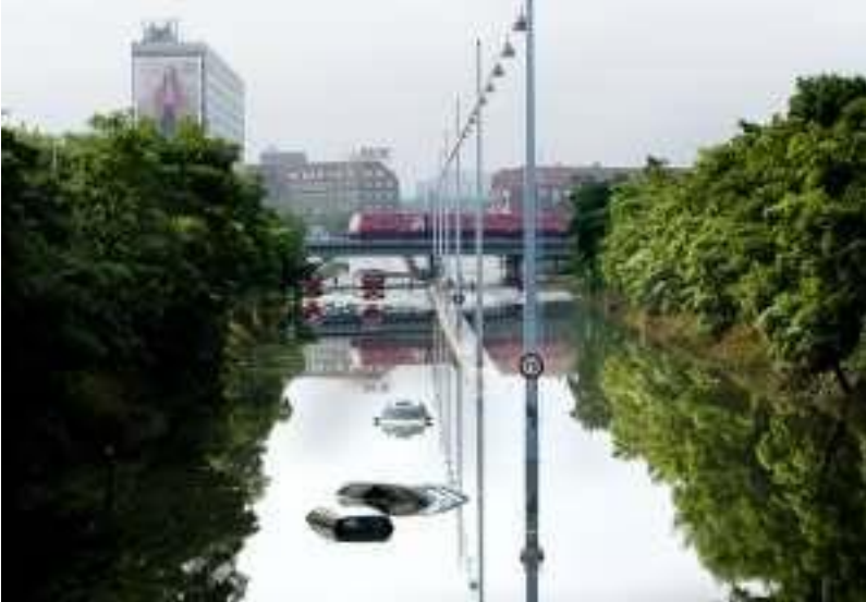
Oversvømmelser ved Ryparken, Danmark 2010
