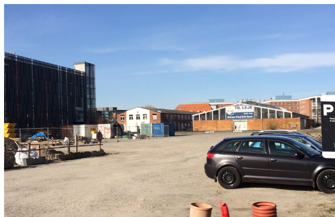
Lokalplanområdet set fra MT-Højgaard's byggegrund fra syd mod nord med p-huset til venstre i billedet. P-huset har plads til 659 biler og kan opfylde behovet for parkering i konstruktion i lokalplanområdet samt medvirke til at begrænse parkeringen på terræn. Bagerst i billedet ses 'Hollelsen Hallen', der ønskes nedrevet samt 'baghuset' til Teglhølmegade nr. 2 /Scandiagade nr.13.
