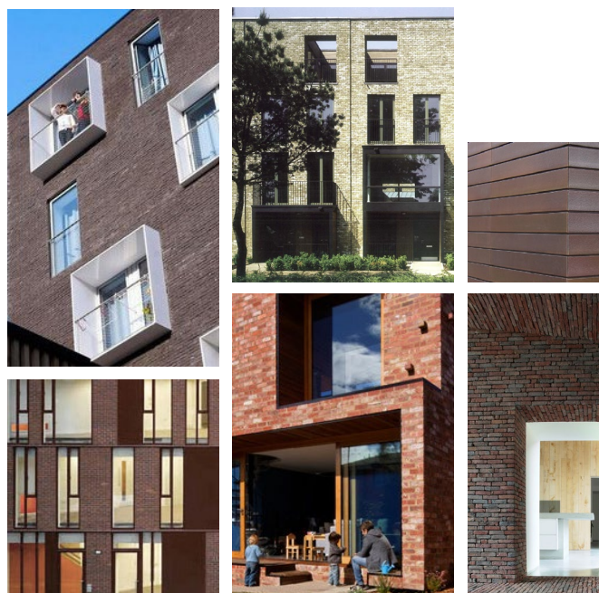
Referencer på facademateriale i form af rødbrune tegl, skærmtegl, lakeret stål m.v. samt variation i udformningen af vinduer, karnapper og 'murhuller'. Fotos: Entasis.
