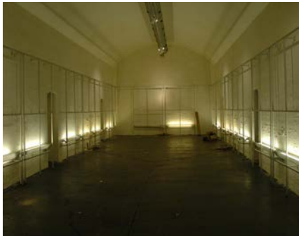
Den eksisterende kælder under pladsen.
