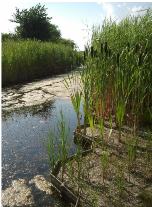
Figur 36. Den landskabelige kanal, er etableret med en hård, lodret kant af metal og beton
