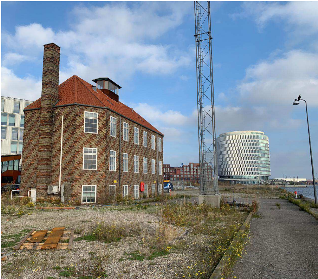
Figur 14-2. Lodseriets murværksmønster og skorsten er velbevaret. Rytterlys fremstår også i oprindelig stand.
