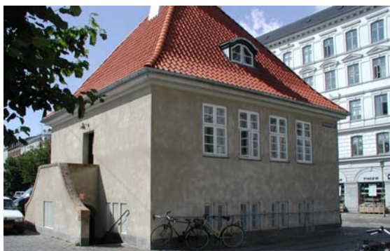
Toilet ved Israels Plads – ønskes bemanded
