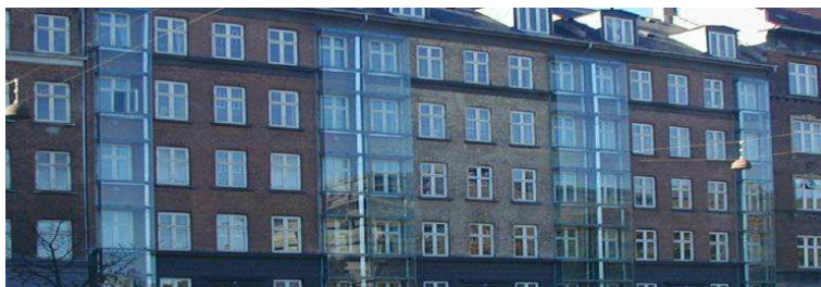
Eksempel på facadeinddækning fra Fredensgade
