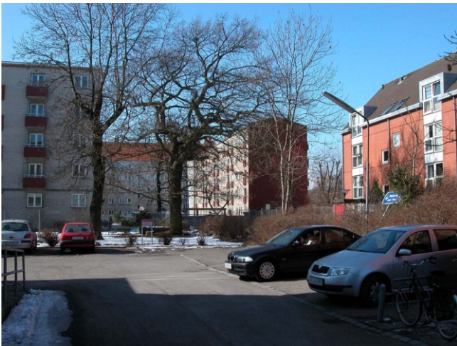
“Hul” i facaden mod Tycho Brahes Allé
