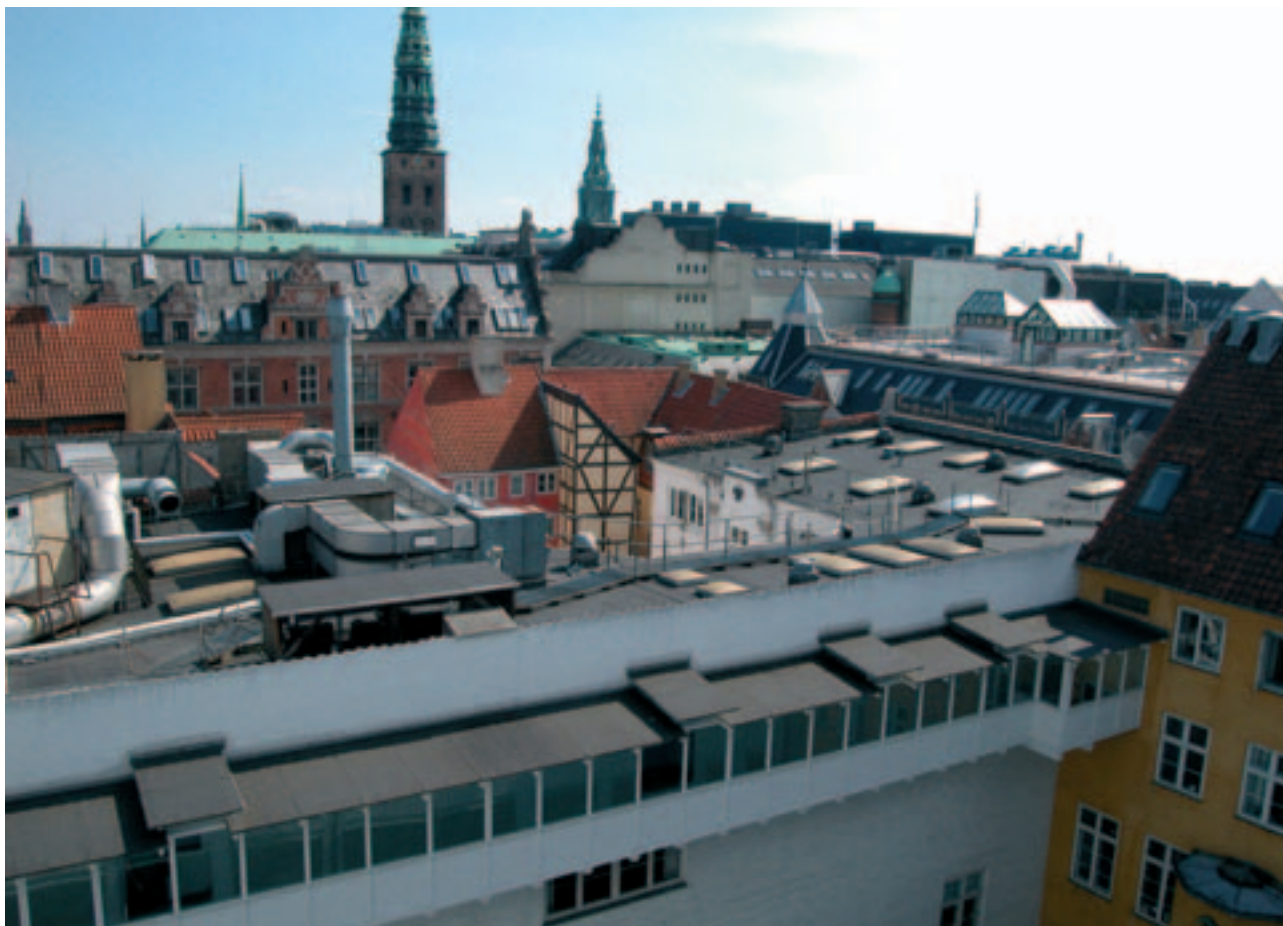
Vue henover karreens tage. Bygningen med svalegang og ventilation er baghuset af Pilestræde 32, som ønskes nedrevet for at give plads, lys og luft til et gårdanlæg.
