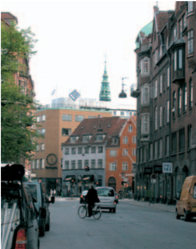
Gammel Mønt og karreen set fra Christians IX's Gade med vue til spiret af Nikolaj Kirke. Dette vue skal bevares. På billedet ses eksisterende skæmmende ventilationsanlæg på taget af karreen, som forudsættes fjernet ved en eventuel påbygning. Ventilationsanlægget har en højde svarende til en etage. Ny påbygning må således ikke være højere end dette.
