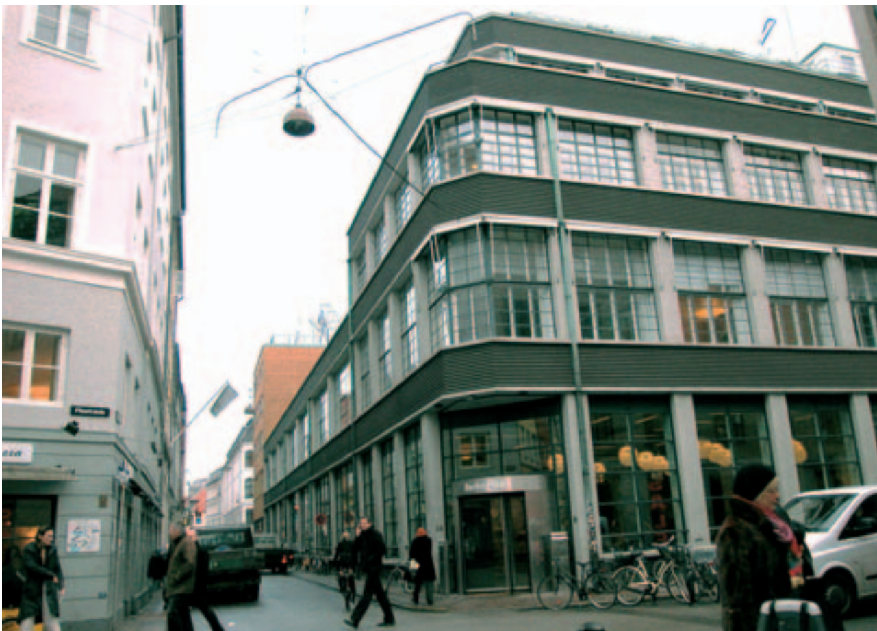
Hjørnet af Pilestræde / Sværtegade. Pilestræde 34 er opført 1928 af arkitekt Bent Helweg-Møller og præmieret af Københavns Kommune i 1931. Bevares til kontorformål.
